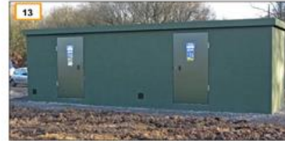
13 Remblaiement du poste de livraison électrique terminé
