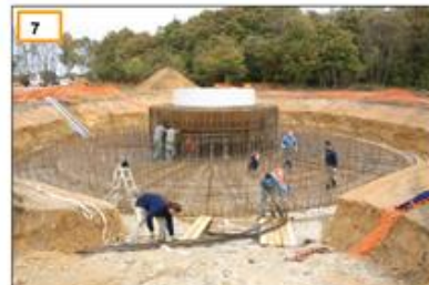
7 Ferrailage de la fondation de l'éolienne en cours
