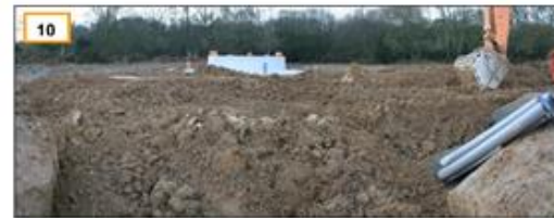
10 Remblaiement de la fondation de l'éolienne en cours
