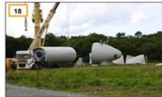
18 Livraison d'une section de mât
