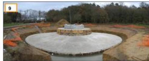
9 Coulage du béton de l'éolienne terminé
