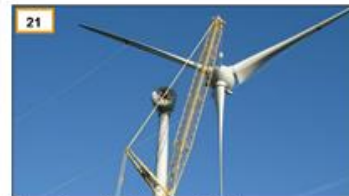
21 Assemblage du rotor sur la génératrice
