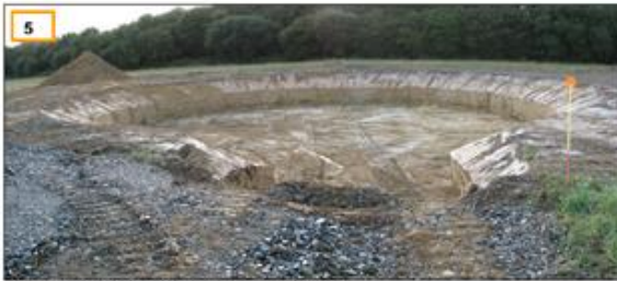
5 Fouille à l'emplacement de la future fondation
