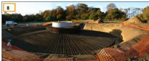
8 Ferrailage de l'éolienne terminé
