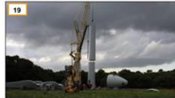
19 Assemblage d'une section de mât
