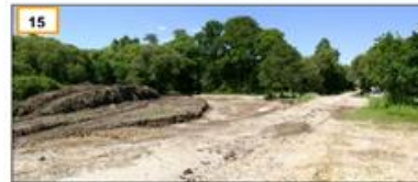
15 Réalisation des aménagements provisoires pour les convois
