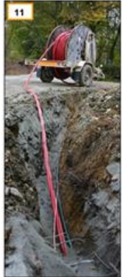
11 Pose des réseaux
