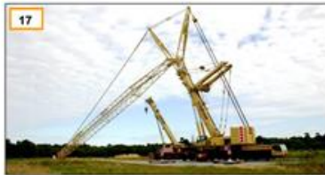
17 Assemblage des éléments de la grue
