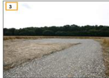
3 Plateforme et chemin d'accès de l'éolienne terminée
