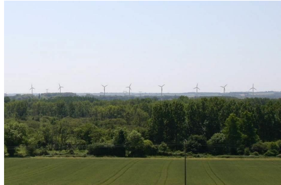
Photo réalisée à l'issue du montage des éoliennes de Chicheboville et de Conteville (14)
