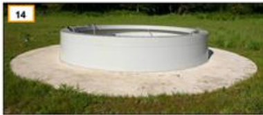
14 Fondation finalisée et prête à recevoir le mât
