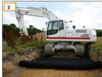
2 Mise en place du géotextile + empierrement
