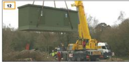
12 Livraison de poste électrique en cours
