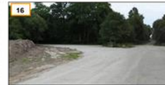
16 Aménagements provisoires finalisés
