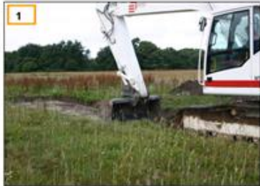
1 Début des travaux : chemins d'accès aux éoliennes
